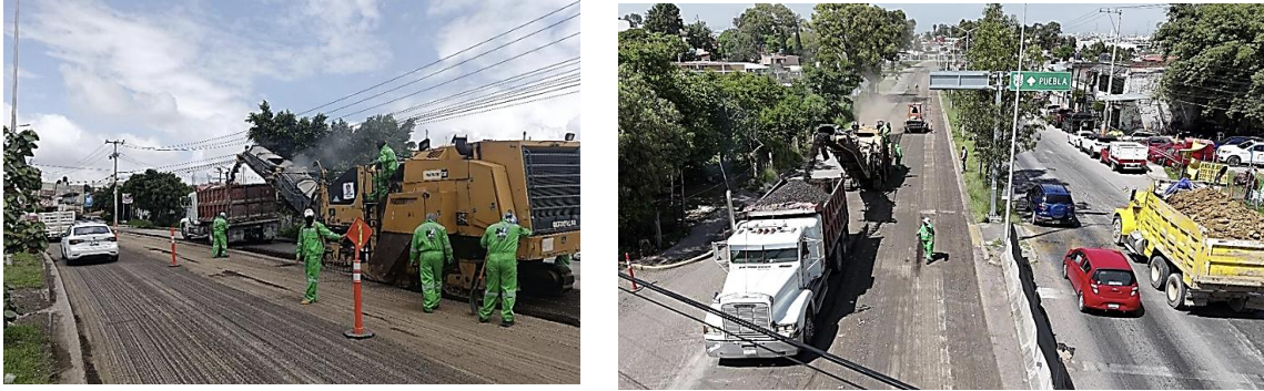
Ilustración 2. Recuperación de pavimento, Puebla, Fuente: Ing. Arturo Domínguez.
